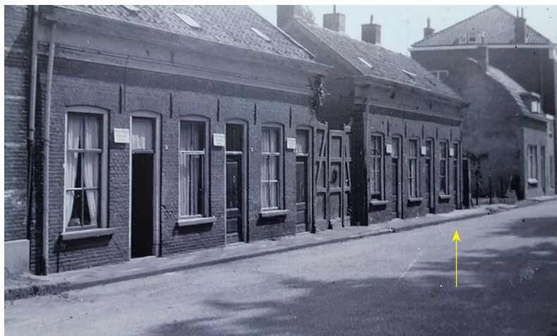
24. Het huis aan de Achterweg had een voordeur en een raam in de voorgevel. Collectie Flipje en Streekmuseum.
